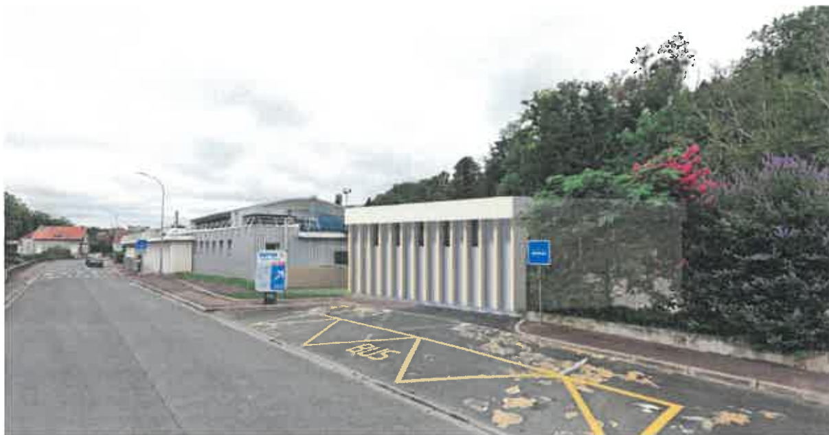
Vue de l'avenue Fernand Tribot : centre aquatique avec l'extension des locaux techniques
