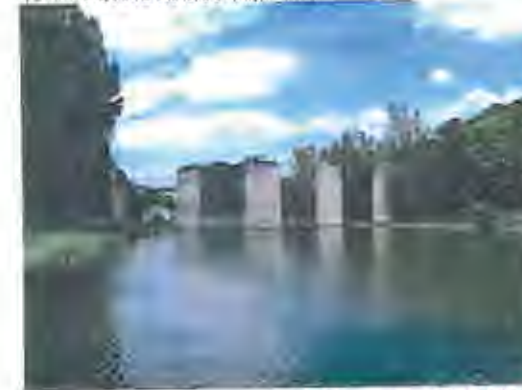
(1) Vue du pont, cliché UDAP 85
