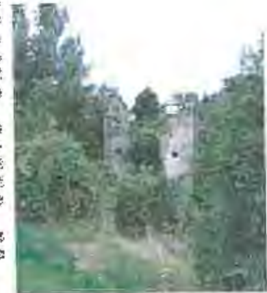
(2) Entrée du pont, Cliché UDAP 85
