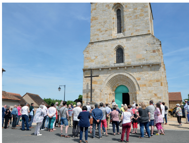
Actualité du patrimoine, visite d'inauguration après la fin de chantier à Brigueil-le-Chantre © Séverine Boulay
