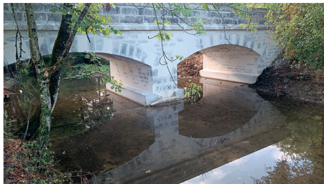
Pont sur la Clouère à Saint-Martin-l'Ars après les travaux
